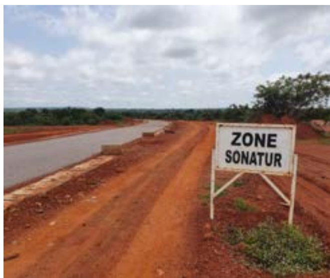
Le goudron ou bitume utilisé est un liquide d'imprégnation «01» qui a été mis en place selon le directeur des travaux.
