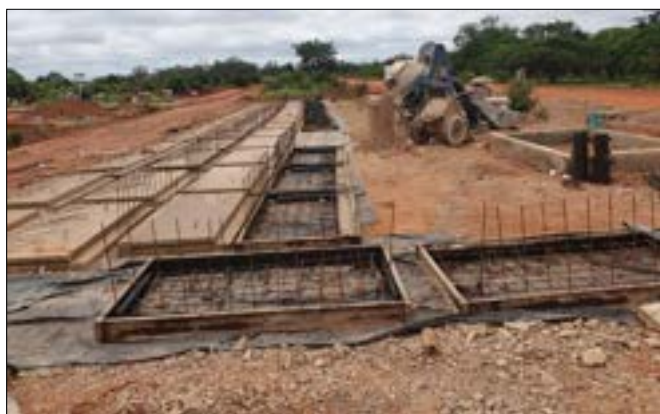
Les travaux de voirie et d'assainissement sont à hauteur de trois milliards huit cent millions de francs CFA (3 800 000 000 FCFA TTC).
